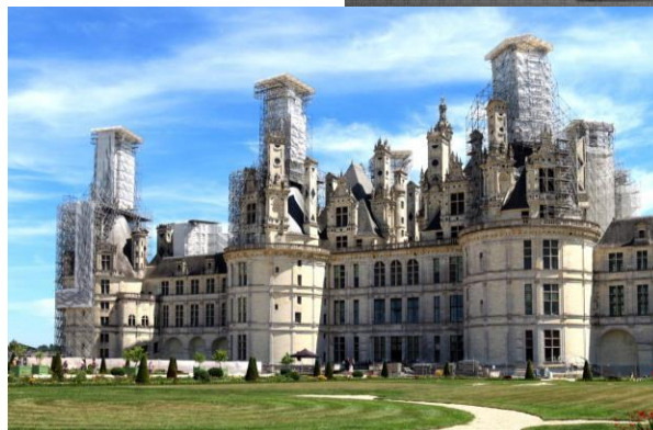
Fațada castelului din Chambord
